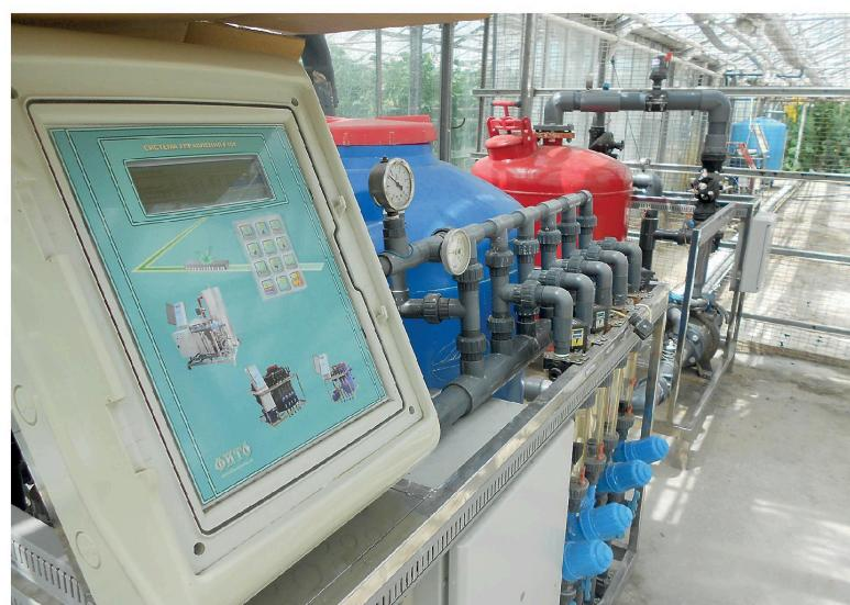
▲ Оборудование для управления микроклиматом, система отопления с разделением контуров, узел водоподготовки изготовлены и установлены фирмой «ФИТО».
